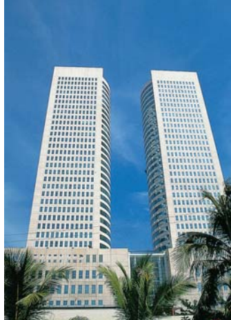
L'ancien fort, aujourd'hui centre commercial résolument tourné vers le XXI e siècle.
